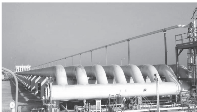
شکل ۱ نمایی از انتهای لخته گیر در تأسیسات تقویت فشار و صادرات گاز سیری
